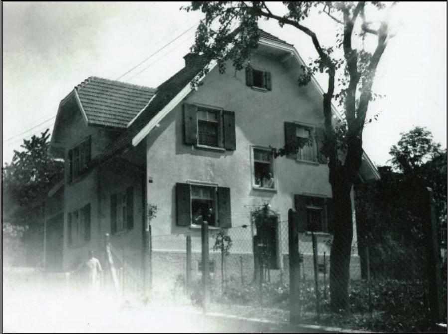
Haus Bühlweg 10 vor der Zerstörung
